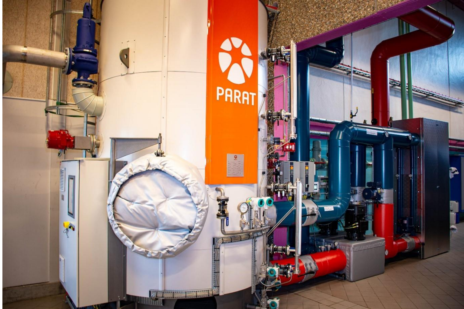
Fjernvarme til Vrøgum
