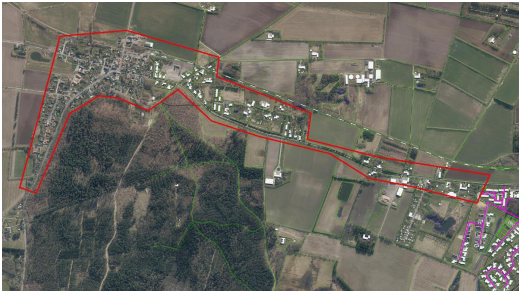
Fjernvarme til Vrøgum
